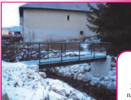
STAV PO REALIZÁCIÍ
